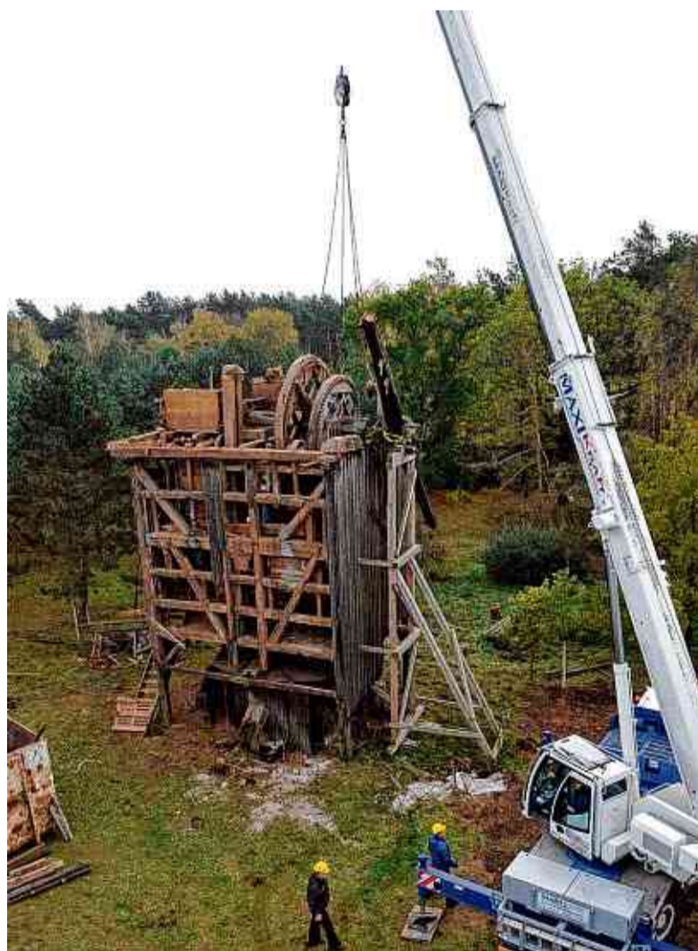
Ende Oktober war die Bockwindmühle in Schweinitz abgebaut und in eine Halle des Lebieni Landguts eingelagert worden. FOTO: ARCHIV/TOMINSKI
