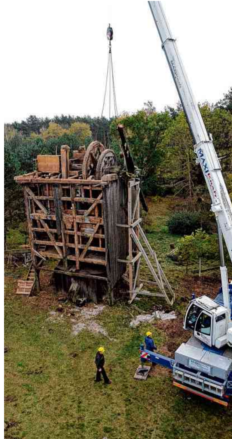
Die Demontage der alten Schweinitzer Bockwindmühle soll bis Ende der Woche fertig sein. In Plossig wird sie restauriert und aufgebaut. FOTOS: THOMAS TOMINSKI
